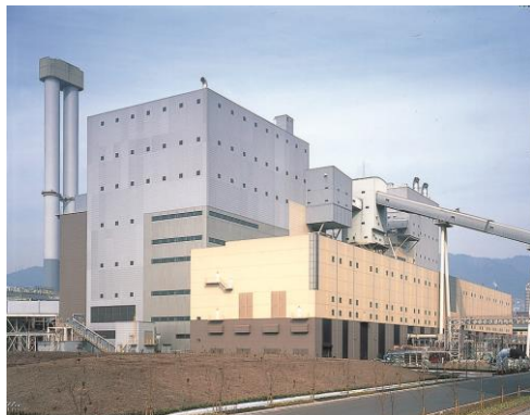
ボイラー建屋
