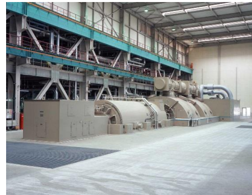
ボイラー1号機
