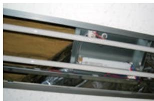
照明に使用されている安定器によっては、内部にPCBが封入されたコンデンサが存在し、昭和52年（1977年）3月までに、新築・改築された建物には、PCBが封入されたコンデンサが使用された照明が設置されている可能性があります。詳しくは、（社）日本照明工業会のホームページ等をご覧ください。
