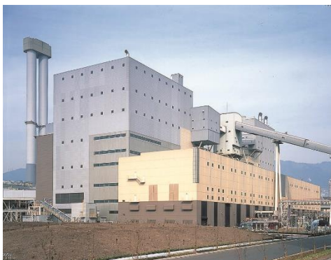
ボイラー建屋
